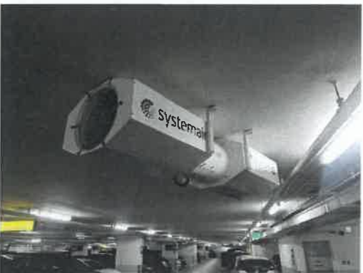
รูปที่ 5 พัดลมดูดอากาศบริเวณชั้นใต้ดิน B1-B2
