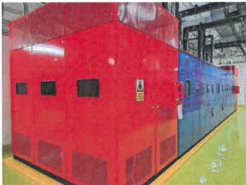
หม้อแปลงไฟฟ้า ชนิด ชนิด Dry Type Case Resin
