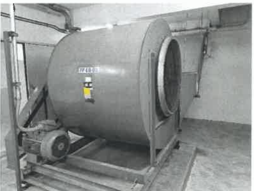
รูปที่ 5 พัดลมดูดอากาศบริเวณชั้นใต้ดิน B1-B2
