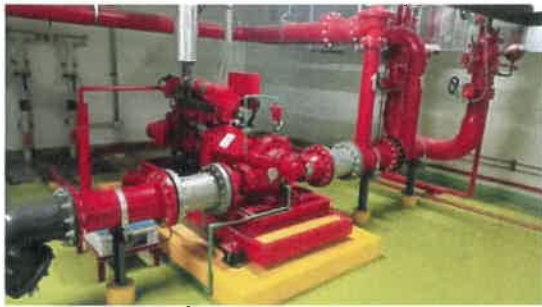
เครื่องสูบน้ำดับเพลิง (Fire Pump)
