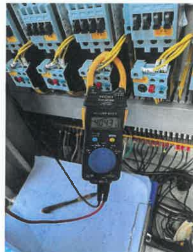
รูปที่ 52 การตรวจสอบเครื่องสูบน้ำภายในบ่อท่่วงน้ำ
